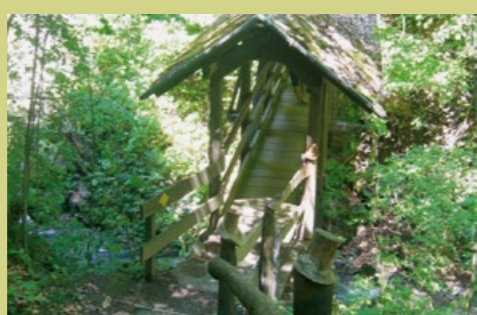
Holzbrücke im Tobel
